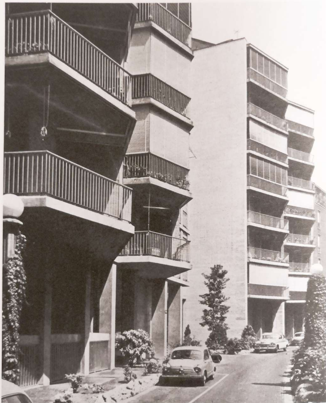
Un particolare della facciata A detail of the façade
