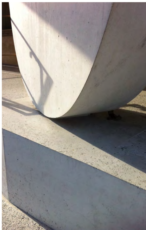
Valerio Olgiati, ingresso pedonale e pensilina della sede del Gran Consiglio grigionese e Teatro comunale, Coira, Svizzera, 2007-2012. Fotografie di dettaglio del supporto semi-ellittico della pensilina
