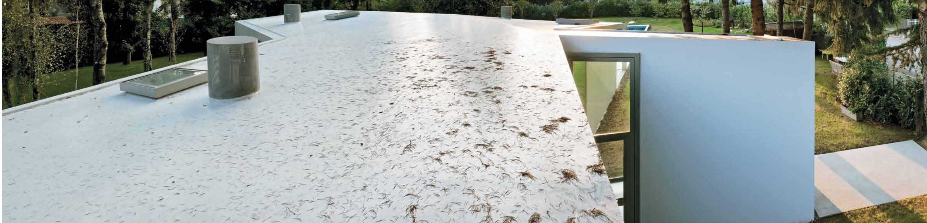
struttura e dei tamponamenti è composto da una impermeabilizzazione continua con guaina liquida di cemento, sufficientemente elastica per evitare le crepe, rasata con strati di resina colorata di bianco.
